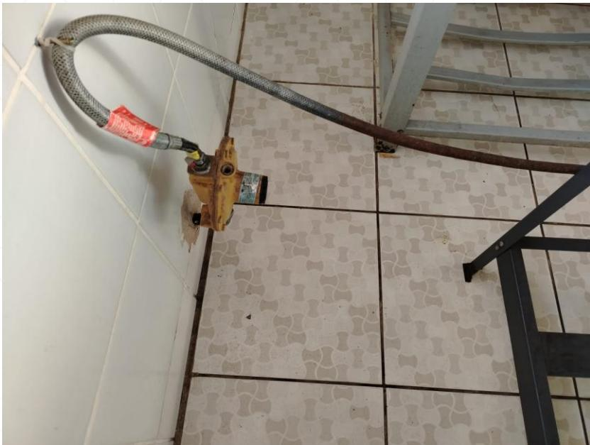
VALVULA DE PRESSÃO SEM DATA DE FABRICAÇÃO E VALIDADE, COM MANGUEIRAS VELHAS SEM REGISTRO DE DESLIGAMENTO DO FOGÃO
