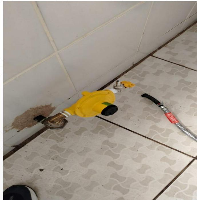
VALVULA DE PRESSÃO NOVA, COM DATA DE FABRICAÇÃO E VALIDADE DE 5 ANOS E MANGUEIRAS NOVAS COM REGISTRO DE DESLIGAMENTO DE CADA FOGÃO E FORNO
